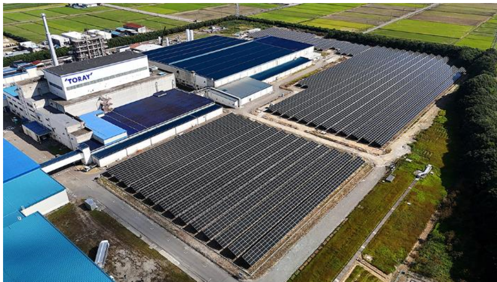
<工場および設備写真>
