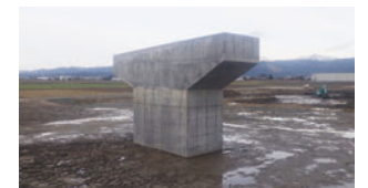
公共工事における施工例(橋脚工事)
