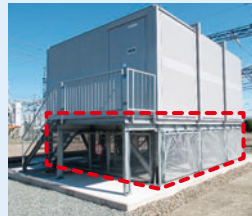
建物の嵩上げ
