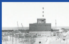
富山火力発電所1号機
