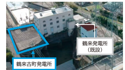
鶴来古町発電所の全景
