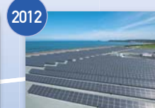
三国太陽光発電所
