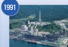
敦賀火力発電所1号機
