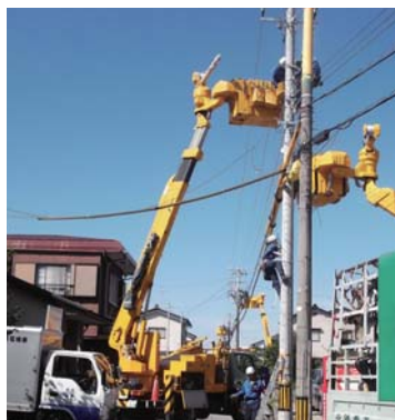
コンクリート柱の建替工事
