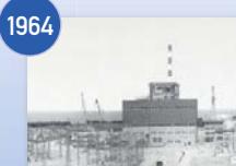
富山火力発電所1号機
