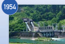
神通川第一発電所(水力)
