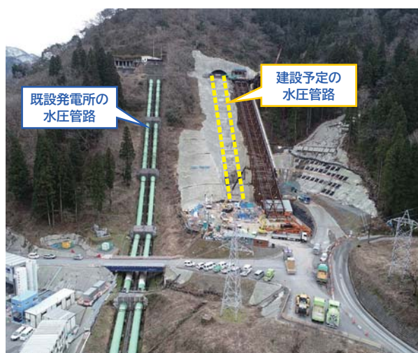
新姫川第六発電所の建設状況（2020年1月）
