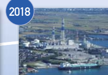
富山新港火力発電所 LNG1号機
