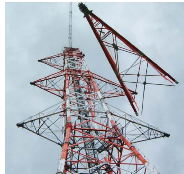
鉄塔組立工事
