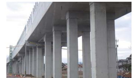
北陸新幹線高架橋
