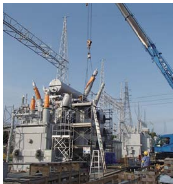
大型変圧器更新工事
