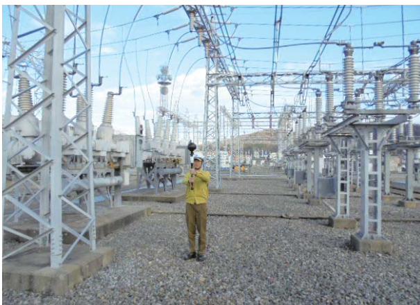
新技術活用による効率化（360°カメラを活用した現場調査）
