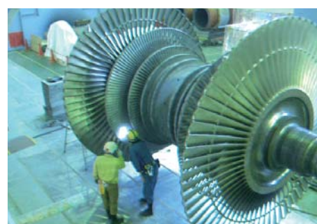
火力発電所定期点検の様子
