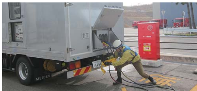
高圧電源車による給電訓練
