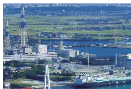
<2018年>富山新港火力発電所LNG1号機運転
