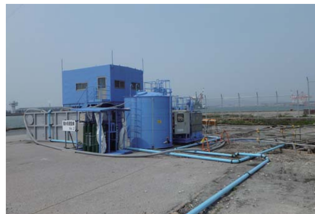
仮設排水処理装置の設置状況
