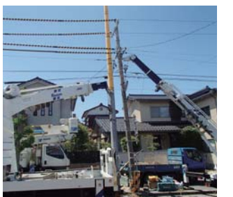
コンクリート柱建替工事
