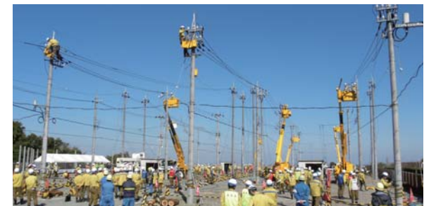
配電工事安全技能大会
