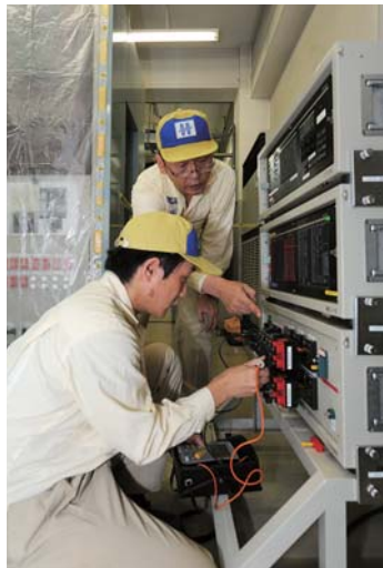
変電所での点検
