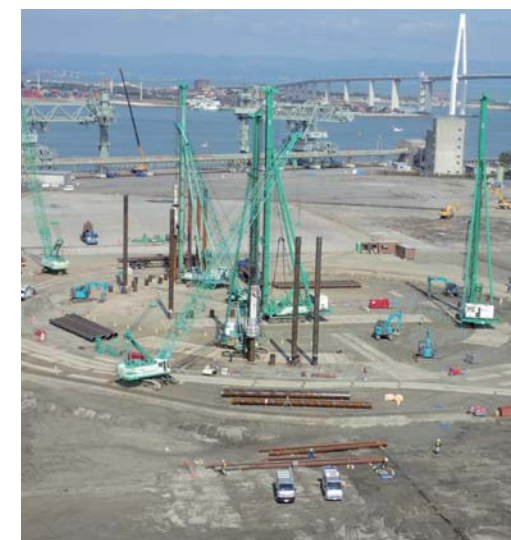
LNGタンク基礎杭打設状況
