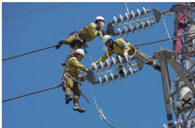
送電線事故復旧訓練
