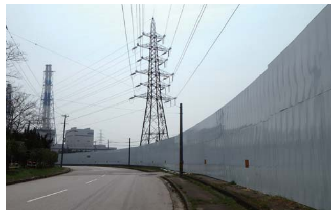
仮設防音壁の設置状況
