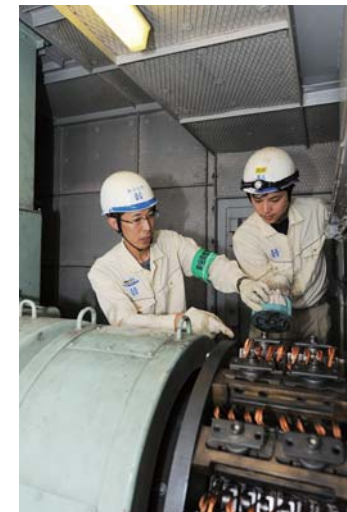
火力発電所での巡視点検
