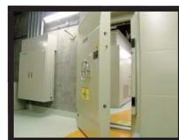
水密扉の設置 ③
