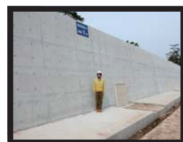
防潮堤の設置 ①
