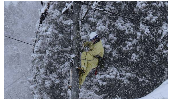
厳冬期での断線復旧訓練
