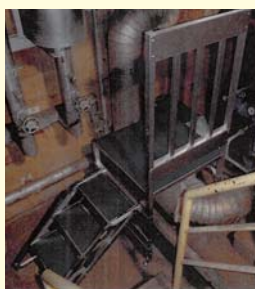
ポンプの巡視点検時に配管を跨いでの転倒を防止するため階段を設置
