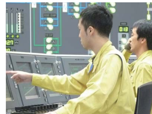
運転訓練シミュレータでの訓練
