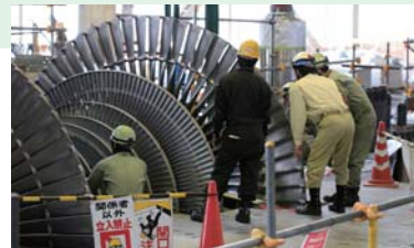
敦賀火力発電所2号機定期点検
