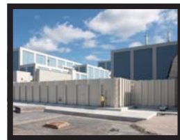
防潮壁の設置 ②
