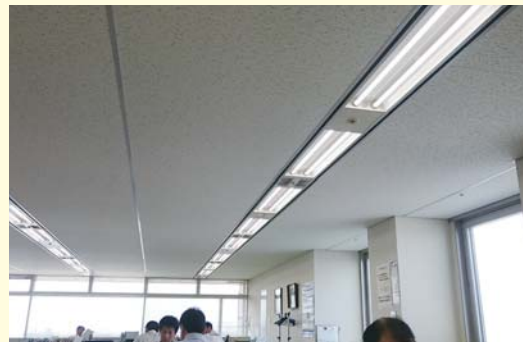
LED照明の導入
