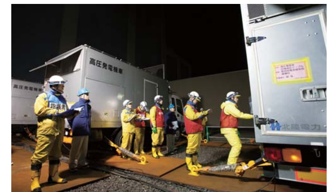
夜間の電源接続訓練
