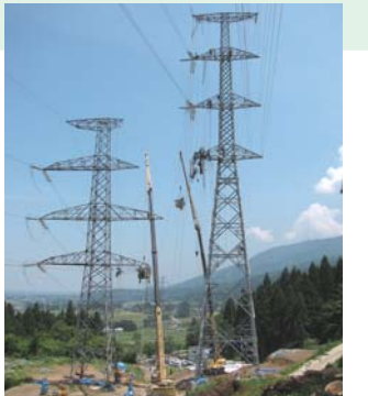
鉄塔建替工事
