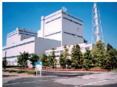
七尾大田火力発電所
