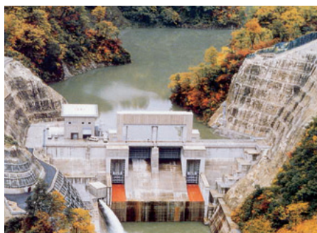
下流への放流状況（北又ダム）
