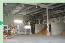
流木の破砕処理
