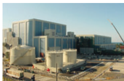
志賀原子力発電所2号機建設状況
