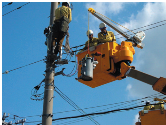
工事技能教育
