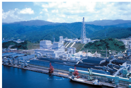
敦賀火力発電所
